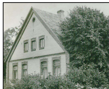
Ehem. Gebäude / Kellerhöher Straße
