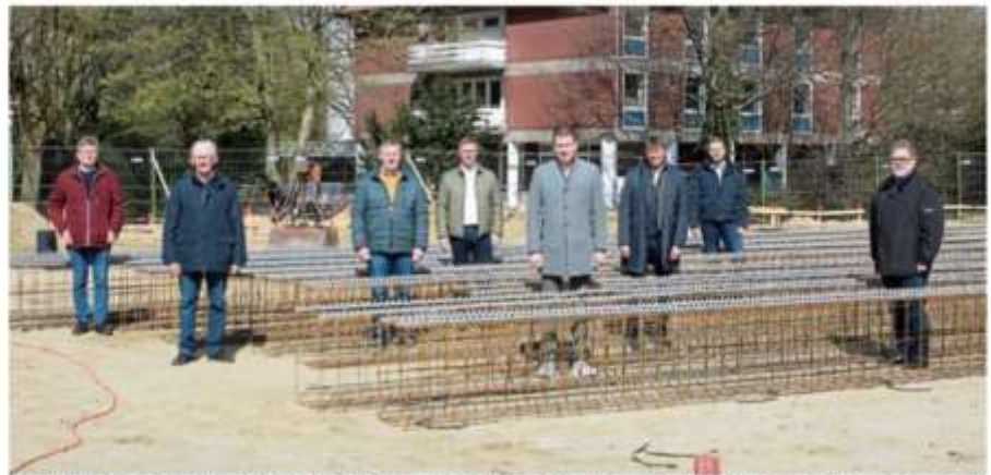
Die Bauarbeiten hinter dem Seniorenheim sind bereits in vollem Gange. Vertreter der katholischen Kirchengemeinde und der Verwaltung sowie Architekt Ewald Wehry (dritter von rechts) kamen am Mittwochmorgen zur Baustelle. BEI: MAREIKE WÜBBEN
