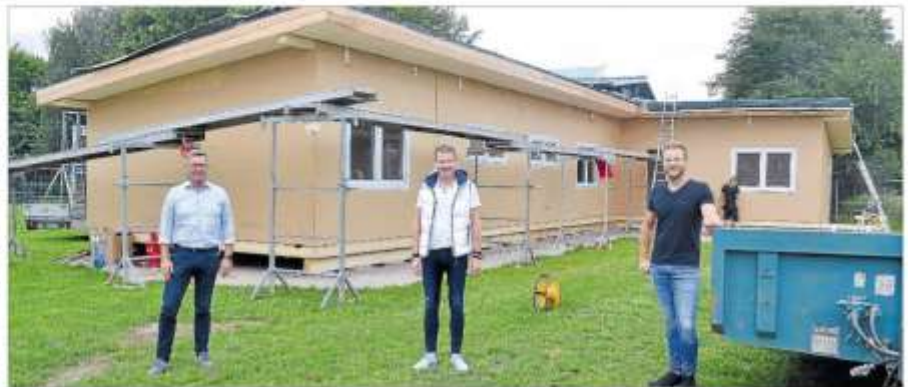
An der Übergangskrippe wird noch gewerkelt: Reiner kl. Holthaus (von links), Michael Fischer und Franz-Josef Rump informierten über das Projekt. Foto: Schrimper
