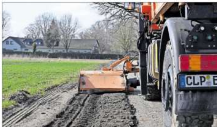
Jedes Frühjahr neu: Das Gemisch aus Schotter und Splitt wird gefräst, begründet und mit einer Walze verdichtet. Foto: Thomas Vorwerk
