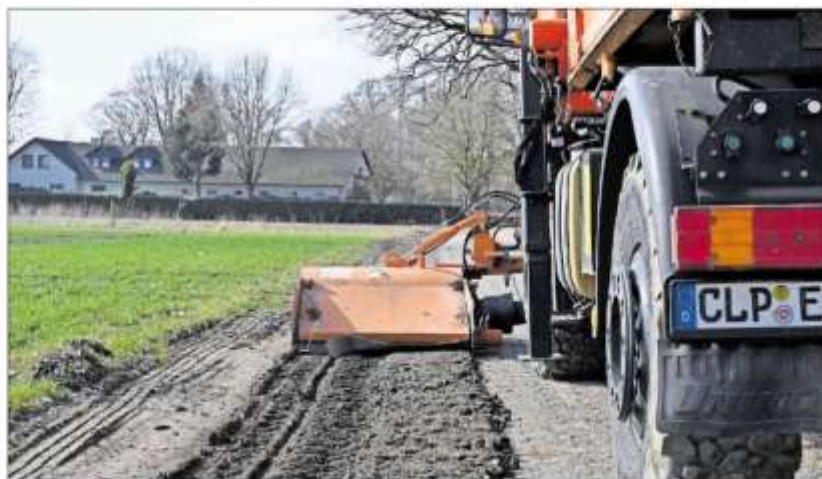
Jedes Frühjahr neu: Das Gemisch aus Schotter und Splitt wird gefräst, begründet und mit einer Walze verdichtet. Foto: Thomas Vorwerk
