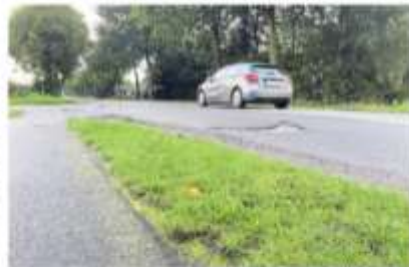
Die Baumwegstraße in Halen soll zwischen Depotweg bis zur Bundesstraße 213 saniert werden. PHOTO: MAREIKE WÜBBEN
