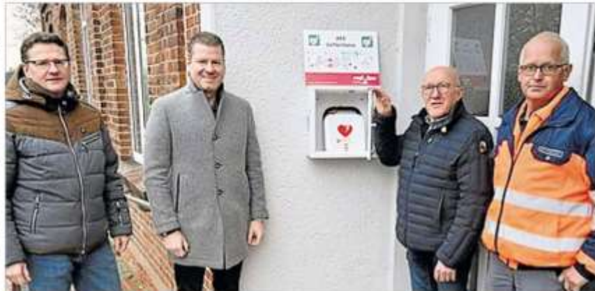
Frei zugänglich: Der Defi in Garthe wurde im Beisein von Christian Klaas (von links), Bürgermeister Michael Fischer, Ludwig Ahrens und Reinhold Niemann vom kommunalen Bauhof installiert.
