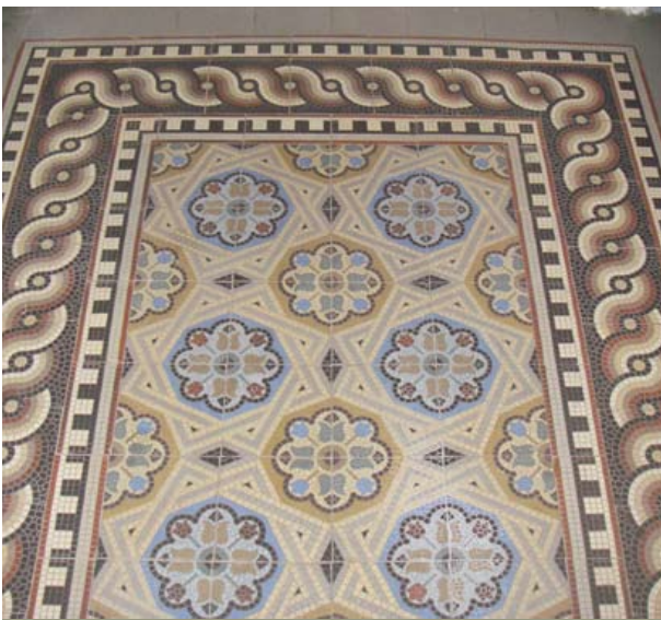
Historische Bodenfliesen neu verlegt
