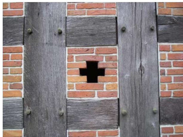
Fachwerkausfachung (Nachgefugt)
