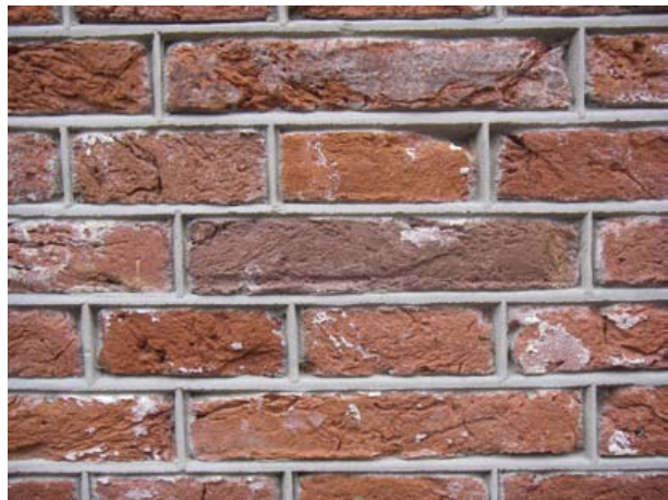
Saniertes Mauerwerk mit Wulstfugen
