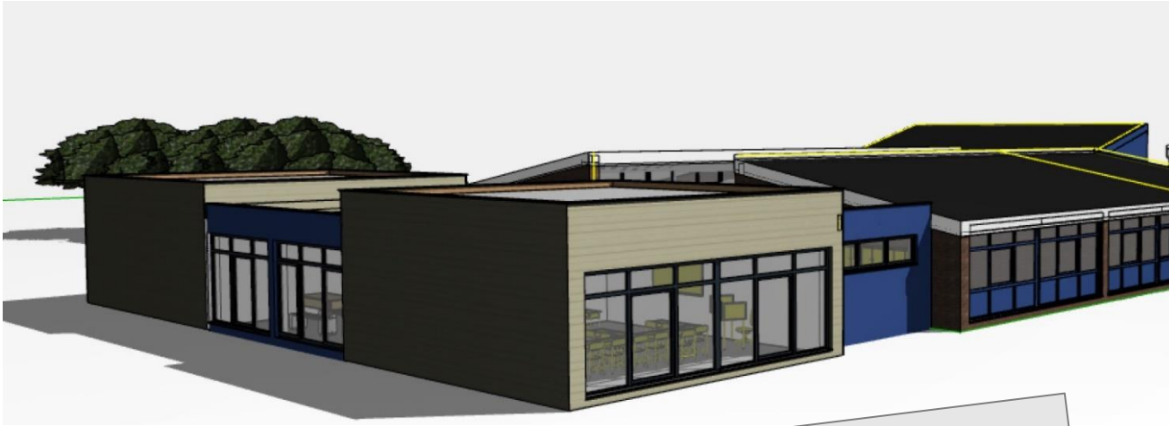
Erweiterung der Grundschule Höltinghausen
