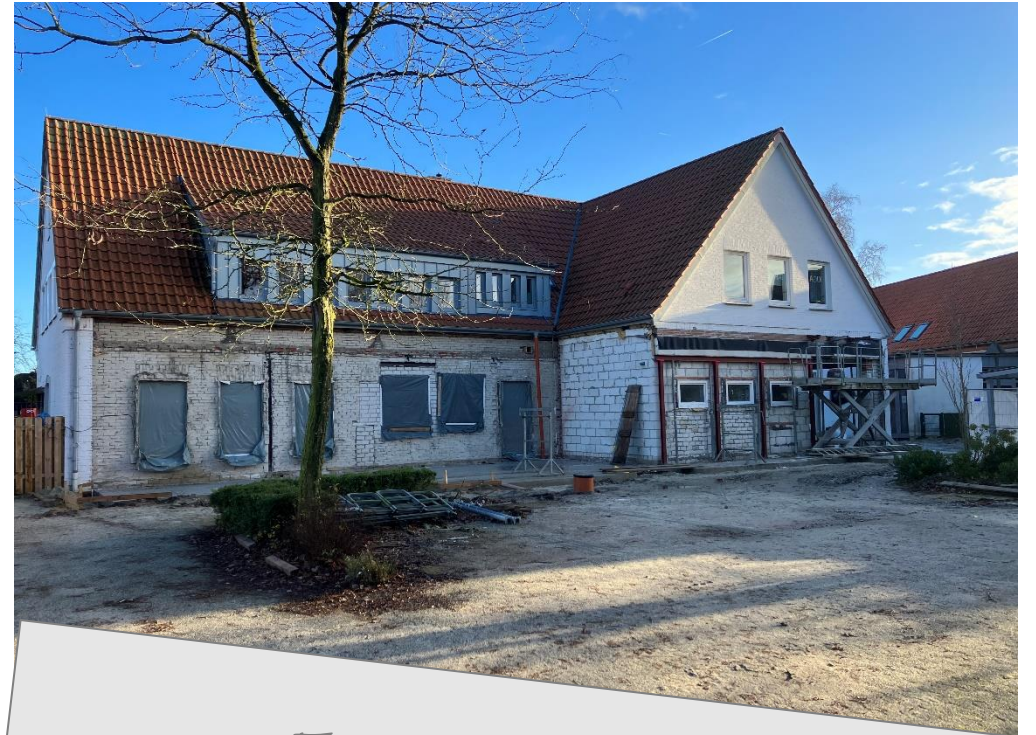
Erweiterung des Franziskus Kindergartens
