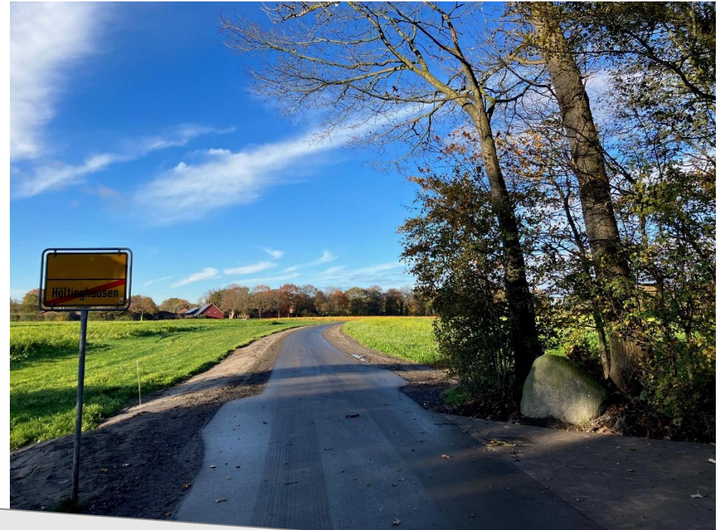
Sanierung der Gemeindestraße „Bether Weg“, Höltinghausen
