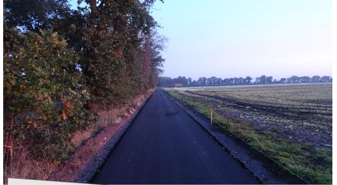
Neubau eines Radweges an der Gemeindestraße „Mittelweg“, Hoheging
